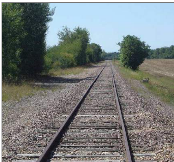
Voie ferrée traversant Coudray (au niveau du croisement avec la RD 131)
