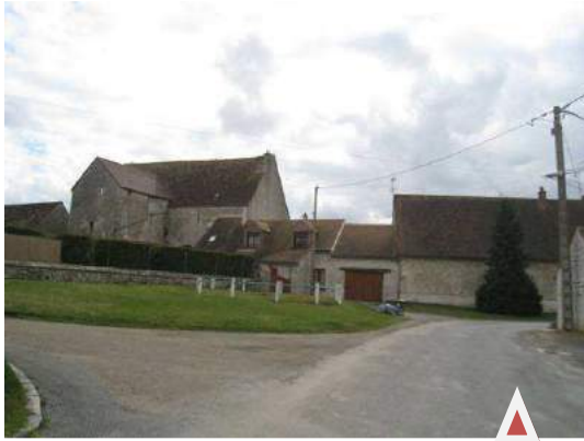
Parcelle 149 Rue du Vieux Puits
