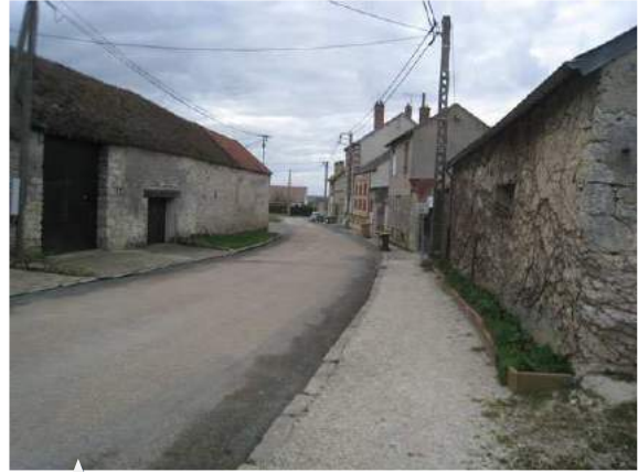
Parcelles 126 127 Rue des Grands Vents
