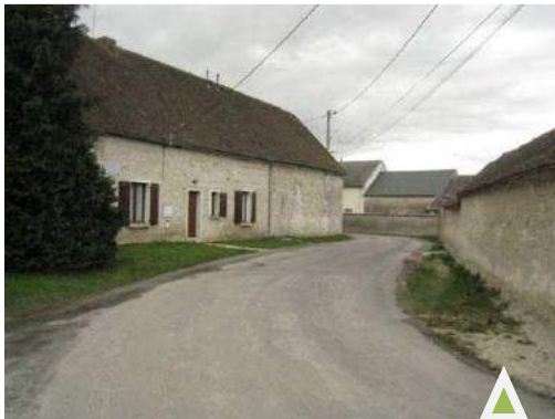
Parcelle 150 rue du Vieux Puits
