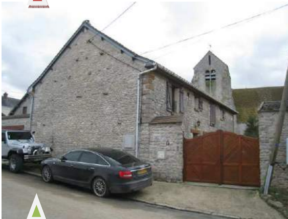
Parcelles 125 126 Rue des Grands Vents
