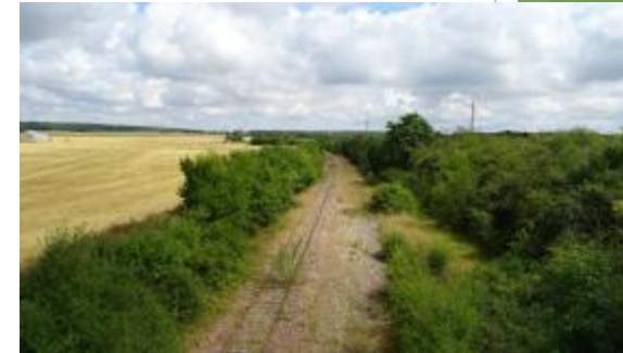
Coulée verte qui accompagne la voie de chemin de fer.
