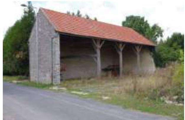
**Intérêt :** Grange vernaculaire en bois, avec pignons et mur arrière en moellons calcaires et poteaux reposant sur des blocs de pierre équarris
