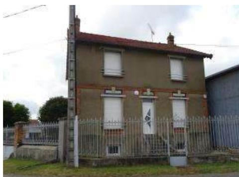
*Filay, maison avec linteaux métalliques, décors en faïence, bandeau et chaînage en briques et tuiles mécaniques.*
