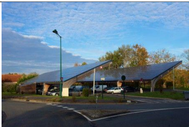
ZAC des Loges – Aire de covoiturage avec des ombrières photovoltaïques
